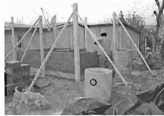
Foto N° 1: Caseta sanitaria piloto sin terminar.
