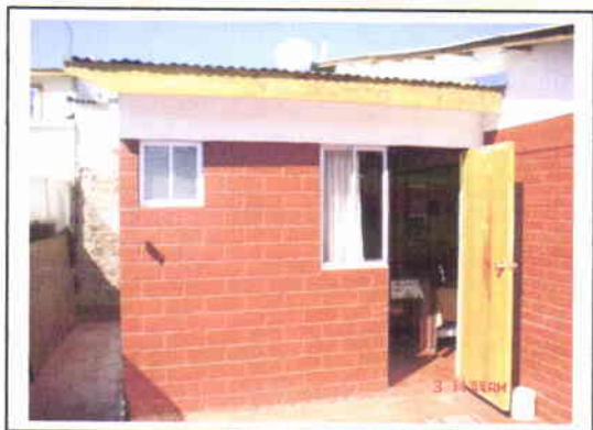
Fotografía 1: proyecto ampliación de un dormitorio en primer piso. Correspondiente a comité de vivienda Mallacura
